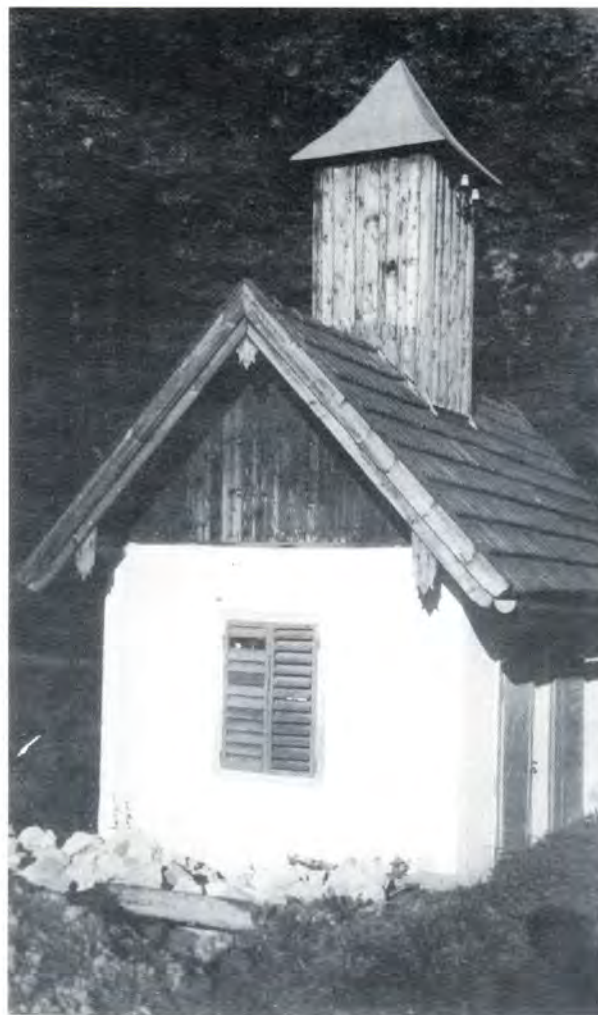
Kleines Wasserkraftwerk am Zellerbach - zur Stromerzeugung für Gasthof Bahn Hier haben ab 1950 Josef und Anna Schafleitner durch Zubau ihr Wohnhaus errichtet. Der Raum des kleinen Kraftwerkes wurde ein Teil des Kellers.
