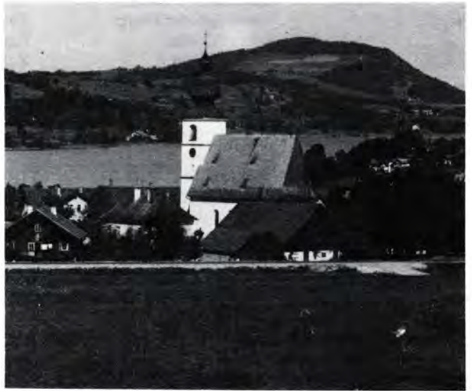
Der alte Pfarrhof war bis 1976 bewohnt. Das Wirtschaftsgebäude wurde 1968 aufgegeben.
